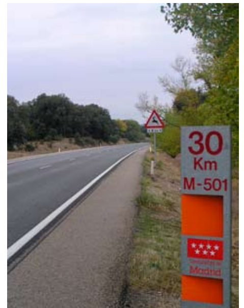
La carretera antes de las obras
