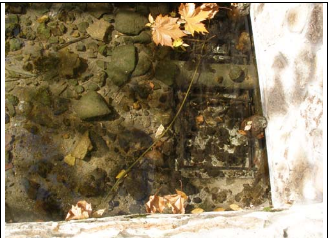
Imagen de la fuente Juncal el 10 de noviembre de 2007. Se ven las piedras en el fondo y los caños cubiertos de agua. Algunas hojas flotan sobre la lámina de agua.
