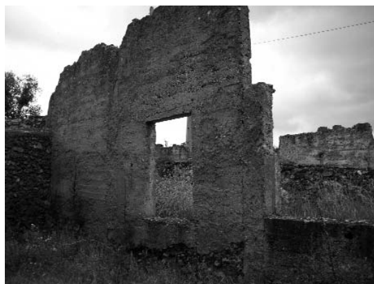
Figura 2.- Ruinas del Destacamento Penal de Garganta de Montes.
