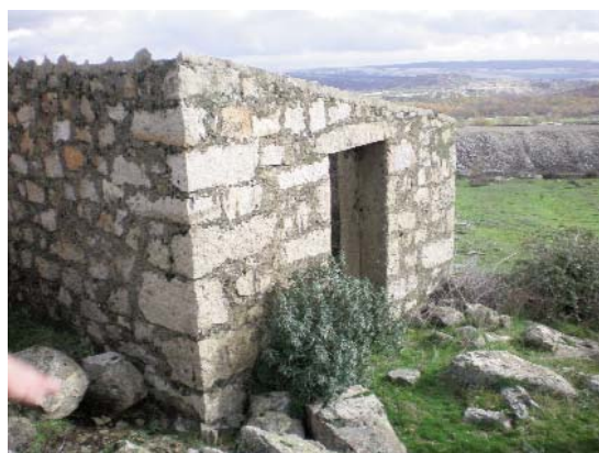
Figura 22.- Edificio de uso indeterminado (estructura 3a).
