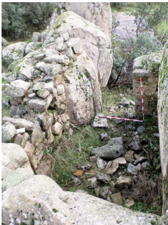
Figura 20.- Restos del polvorín, encajado entre afloramientos rocosos.
