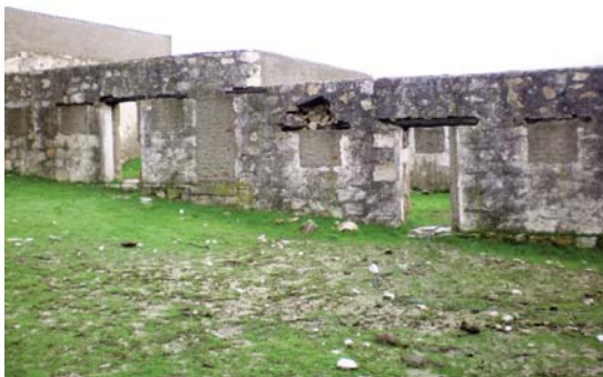
Figura 11.- Fachada al patio de las habitaciones de usos múltiples (cocina, jefatura, economato).
