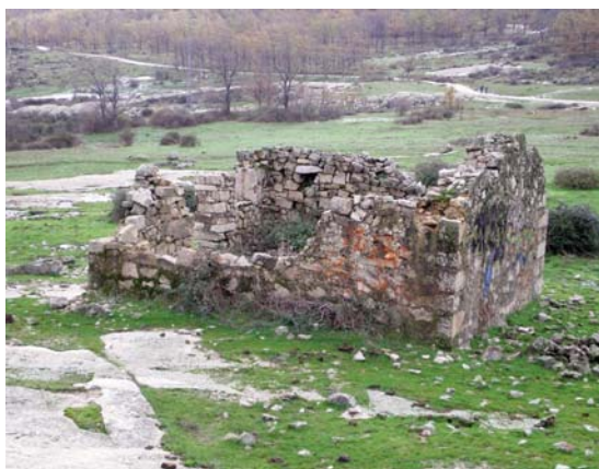
Figura 21.- Edificio de uso indeterminado (estructura 3b).
