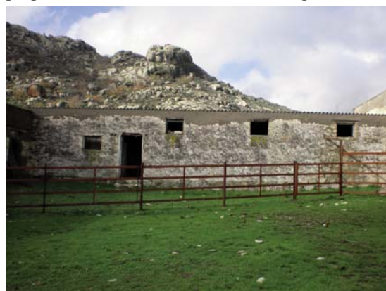
Figura 12.- Fachada al patio de uno de los dormitorios colectivos.
